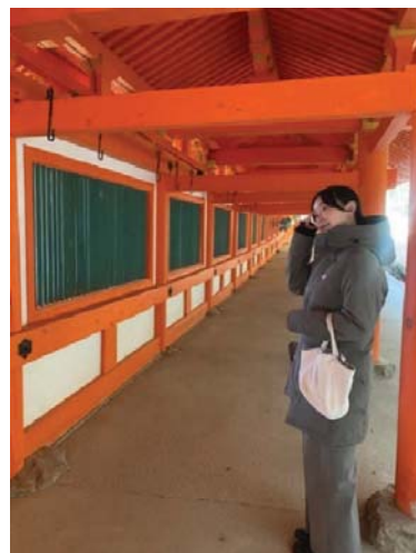
傾斜の残る回廊
